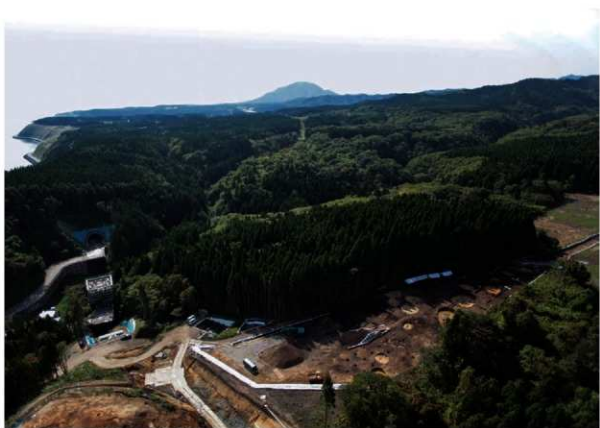
東から館野6遺跡全景 丸山を望む（東から）
