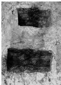
BTP-5 sp-1.2 (南西から)
