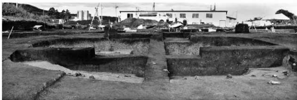
1. H-15 A-Bセクション SW→NE
