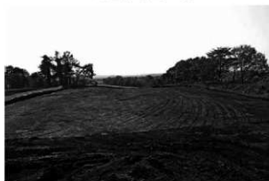
3 平成23年度完掘（北から）
