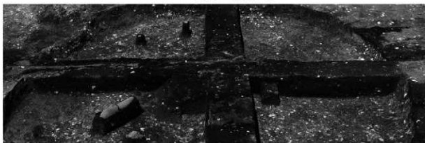
3 H-1 断面2(南東から)
