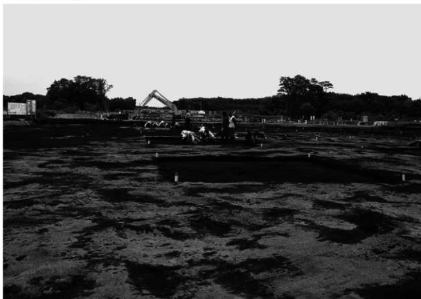
2 C地区25%調査状況
