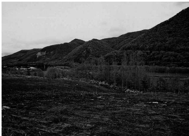
1 D3区表土除去後の状況(西から)
