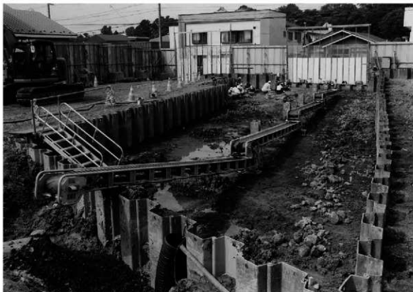
ベルトコンベアー設置
