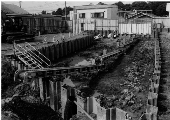
ベルトコンベアー設置
