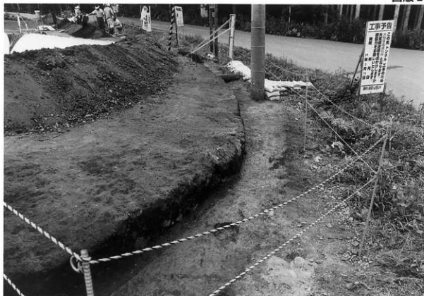
調査区東側法面部分完掘（東側）（南東から）
