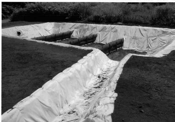
沈砂池設置状況（北西から）
