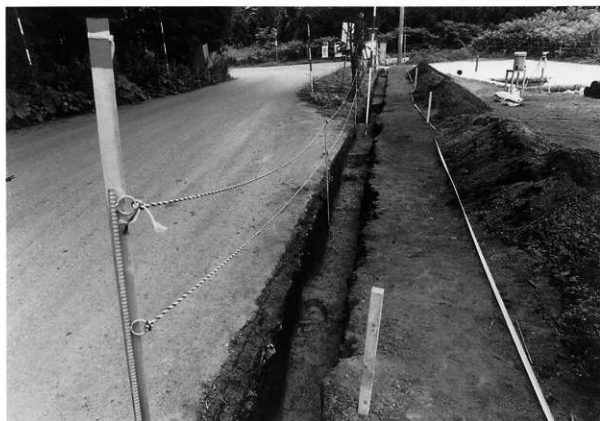
調査区東側法面部分完掘（北東側）（西から）
