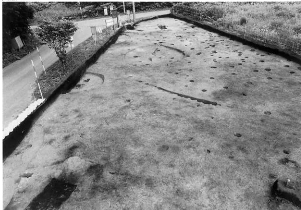
調査区東側完掘（西から）
