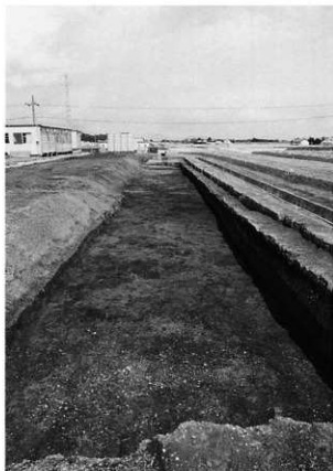
3 防火用水路下完掘（南から）
