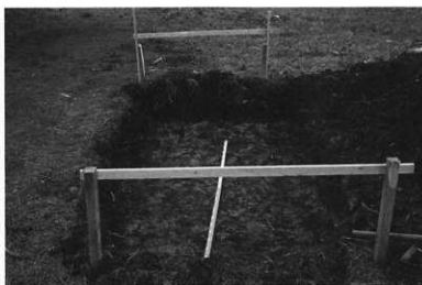
09 B区の完掘状況
