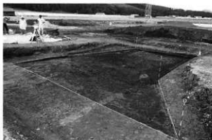
4 鉄塔下 T65・66区表土除去後（南から）
