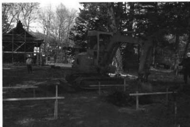
04 鳥居新設地・表土の掘削状況
