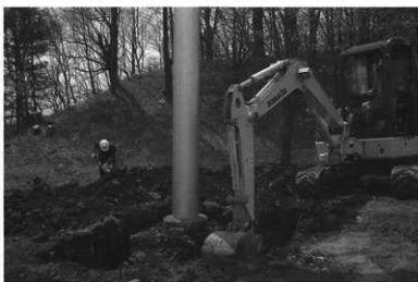
03 旧鳥居の掘り方埋土の掘削状況
