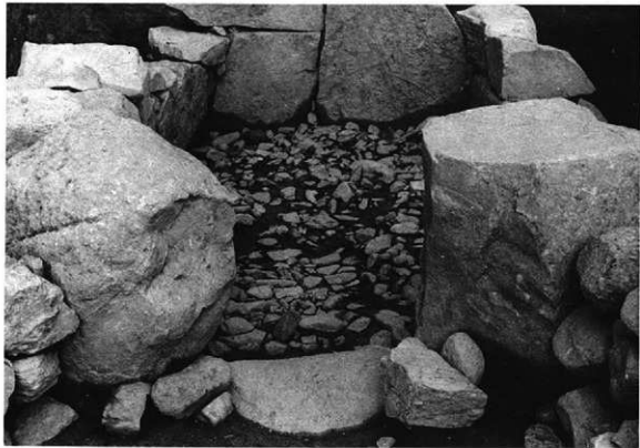
(1) 沙井掛第2号古墳玄門 浜道より (南西から)
