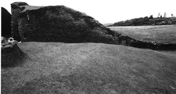
(2) 沙井掛第2号古墳第3トレンチ右側壁側墳丘盛土の状況 (南西から)
