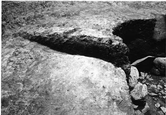
(1) 汐井掛第7号古墳第1トレンチ右側壁側填丘盛土の状況 (南東から)
