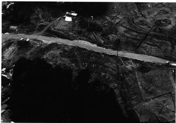
(1) 沙井掛古墳A群発掘前の全景 航空写真 (南西から)
