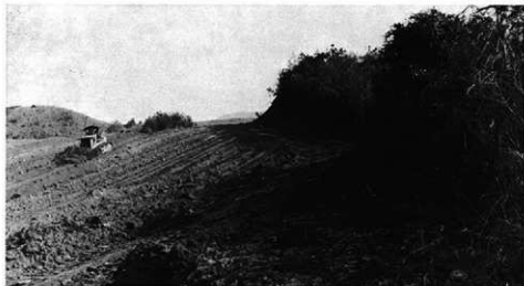
1. 原口B1号 墳北側果樹園 造成工事
