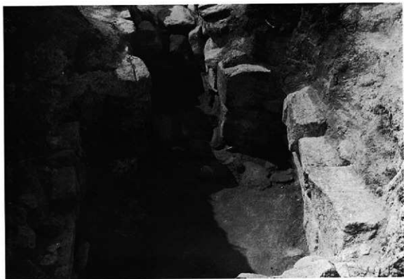
(2) 石室及び閉塞石 (奥壁側より)
