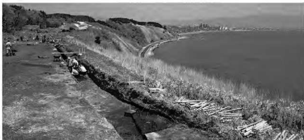
濁水処理施設部分 調査状況
