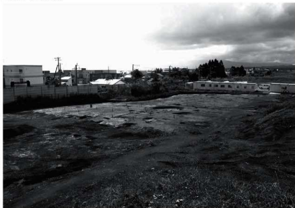
調査区南西側調査終了状況 (北から)
