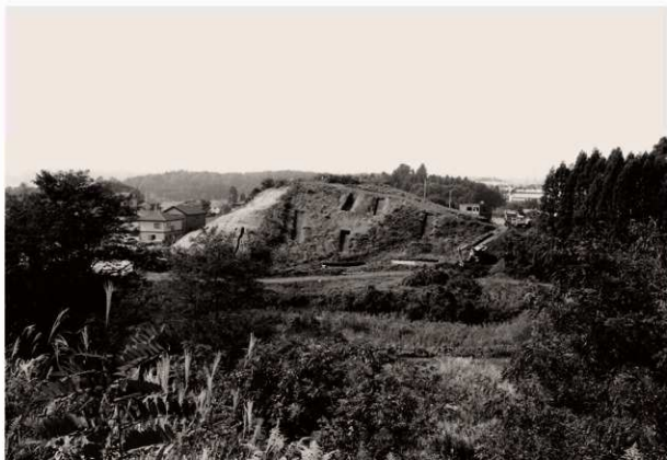
2 栗木内遺跡調査前遠景（2）（東から）
