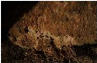
図10：岩体表面の剥離
