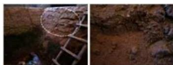
図6 南棟法面の土壌粒子の崩落
