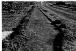
粗掘り終了(表土が薄い状況)
