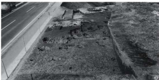
①下段平場新期面遺構検出（西から） ②下段平場新期面遺構検出（北から） ③下段平場新期面遺構検出（南東から）
