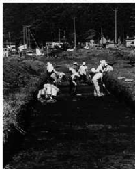
川原平(4) A区 作業風景
