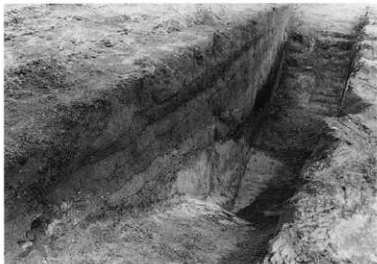
①谷筋土層断面(その1)
