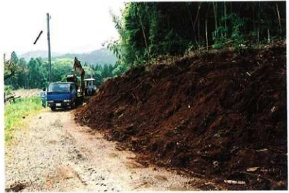
2 重機による表土剥ぎ作業
