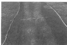
B-IV区 道路遺構(SF1)硬化面
