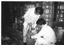
補強柄穴の穿孔作業
