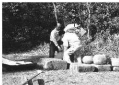
石塔群の復元作業
