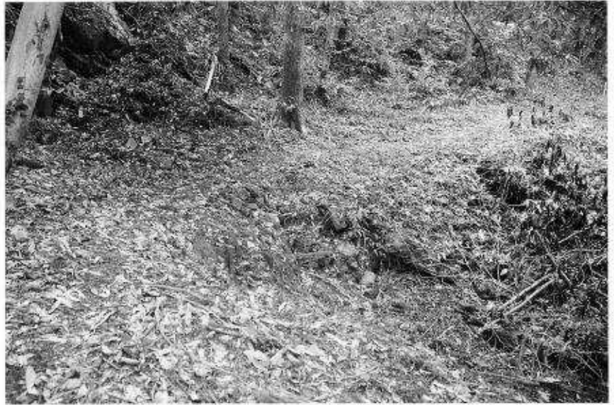
旧街道崩壊箇所
