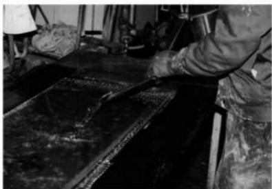
〔写真18〕 過炭酸ソーダの水溶液を注ぐ
