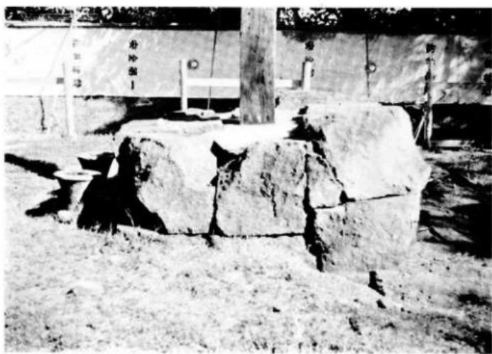
写真2 石子台石侧面 (前の2列が沈下している)
