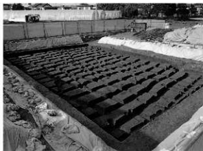
V層上面遺構完掘状況（南東より）
