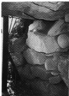
玄室は、西側壁の石材に割れ、クラックが生じている部分があり、東側壁も奥壁側で一部、はらみと石材の崩落個所を川原石で補填した積み替えが行われていた。奥壁は土圧による経年変化としてのはらみが生じていた。しかし、羨道部や前庭部と比較して石積みが精巧なこともあり比較的良好な石積が残っていると判断された。
