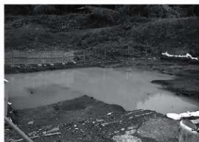
台風13号の雨で水没したB区
