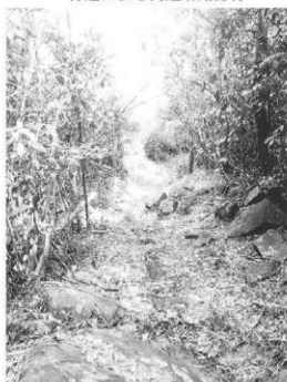
荒廃した街道部分(第7図④)
