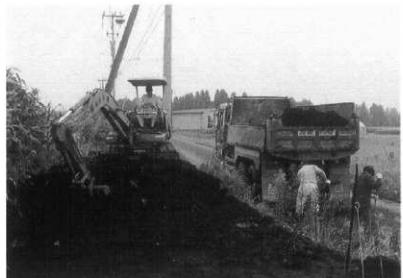
A区 重機による表土剥ぎと廃土の運搬
