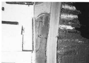
B区中央付近
