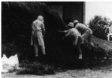
調査風景 石棺を除去後、ノリ面の調査
