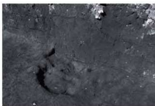
SP3 完露状況(東から)
