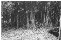
2号盛土(北西より)
