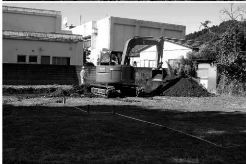
図版4 表土剥ぎ作業 風景
