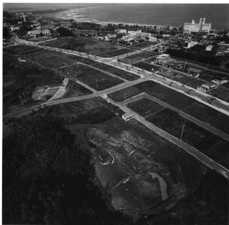
D・E区透景（南より）
