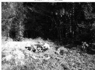
掘削作業風景
