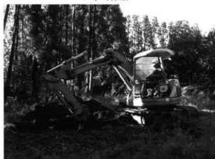
重機による表土剥ぎ
