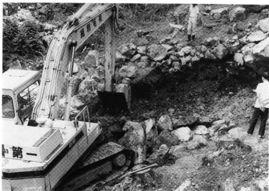
1. 石組前庭部の断割り調査
