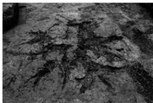
3. SX18 完掘(南西から)
