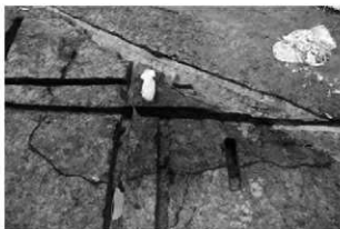
2. SI06 平面形確認状況 (北西から)
