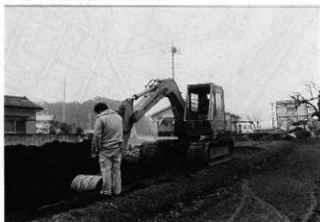
写真18 小蓋林遺跡重機による掘削
