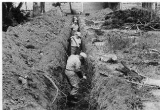
写真3 館林城跡作業風景
