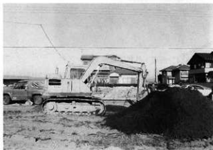
写真42 高根・外和田遺跡重機による掘削
