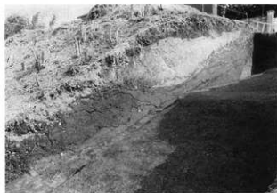
写真27 館林城跡土塁2トレンチ断面
