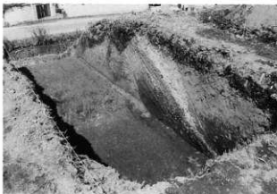
写真24 館林城跡土塁1トレンチ
