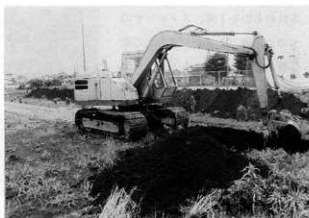
写真11 天神遺跡重機による掘削
