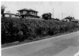
写真20 館林城跡土塁調査前
