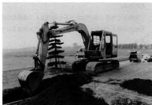
写真38 苗木遺跡重機による掘削
