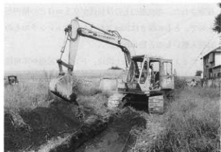
写真 6 大道北遺跡 B 重機による掘削
