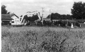
写真3 調査風景（重機）
