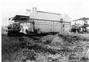
写真20 調査風景（重機）
