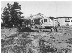
写真 28 調査風景 (重機)
