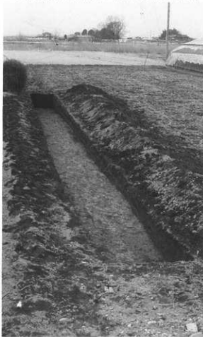
写真 31 1トレンチ全景（県道より）
