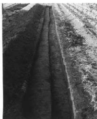
写真30 トレンチ完掘
