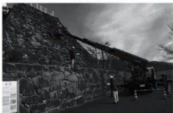
一次点検(高所作業車によるゲージ計測作業)
