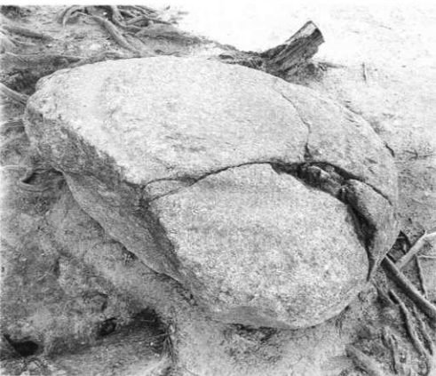
(2) 塔周辺礎石E (北西から)
