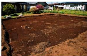
第5次調査区全景（南西から）
